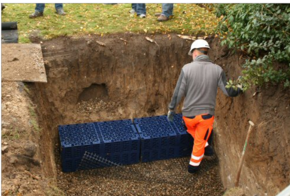
Nedgravning af faskine
